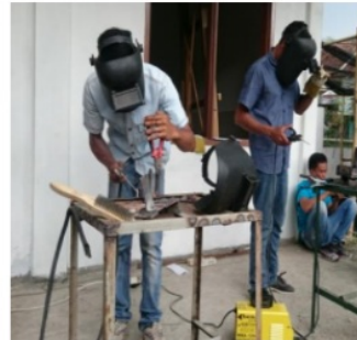
Gambar 12. Pembuatan sambungan las
