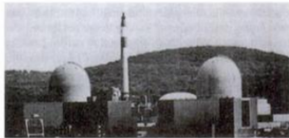
Gambar Pusat pembangkit listrik tenaga nuklir Indian Point milik perusahaan Consolidated Edison. (Sumber: Consolidated Edison.)
